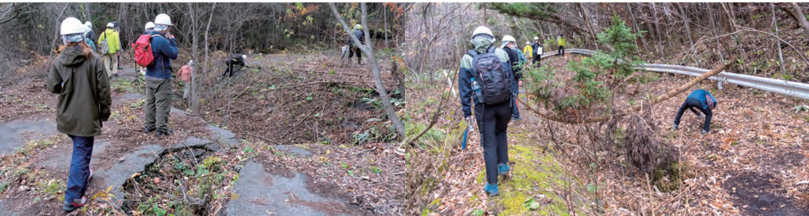
大きな亀裂で寸断された道路を渡る参加者
