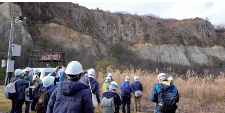
荒砥沢地すべりの滑落崖を見上げる参加者
