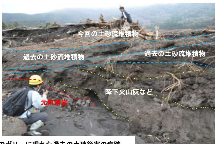
神達地区のガリーに現れた過去の土砂災害の痕跡
