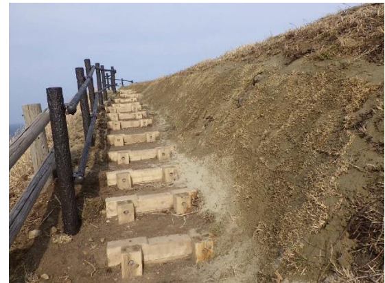
木階段、手すりの更新
