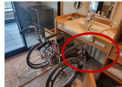
車椅子での洗面・浴室の利用が可能な客室整備
