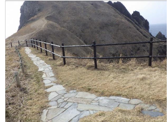
転落防止柵の更新
